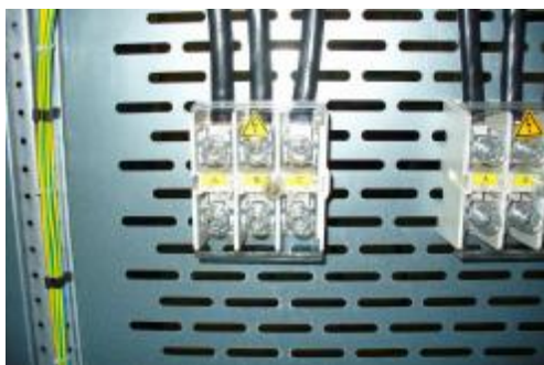
Рис. 4. Отсек кабельных присоединений.
