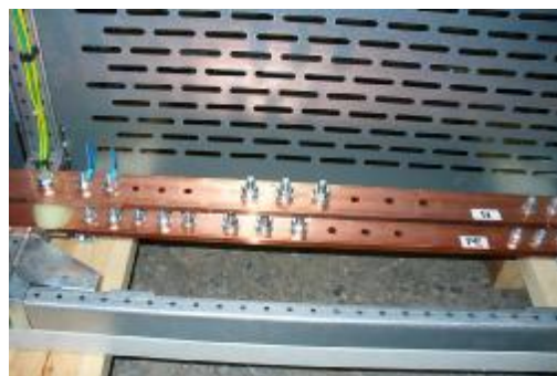
Рис. 5. Нулевая и защитная шины.
